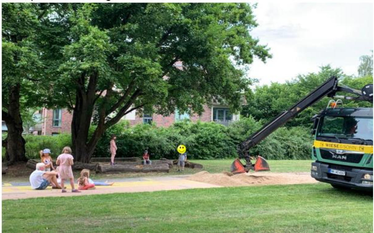
Wir guckten gerne dem Bagger zu, wow, wie spannend der sich bewegt 😊
